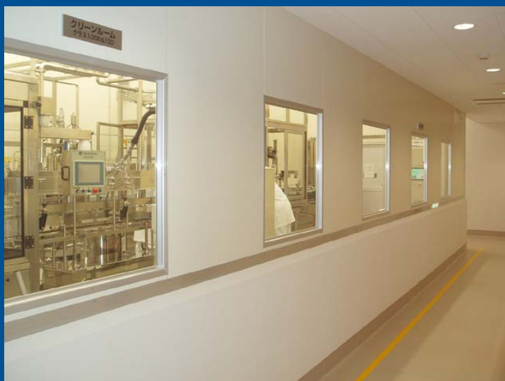
見学者通路から見た無菌充填室（クラス1000）
